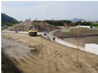
新しい水路等が造られている
